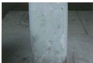
4 補修完了状況 表面研磨仕上げ
