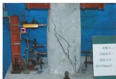
6 せん断破壊試験状況 負側 1/50 第1回目 せん断破壊位置は、注入位置ではなくオリジナルコンクリート。
