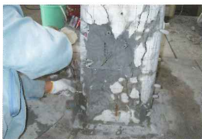
2 欠損部の修復状況 使用材料 IPH#600
