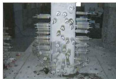
3 エポキシ樹脂低圧注入状況 IPHカプセル 注入圧力 0.06N/mm 2
