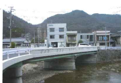
6 完成 (橋梁全体)
