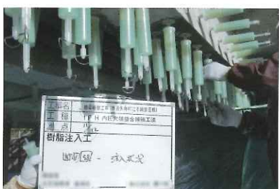
4 注入硬化養生 (IPHカプセル)
